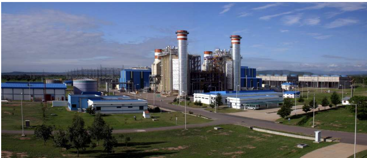
Central TermoAndes, Salta, Argentina
