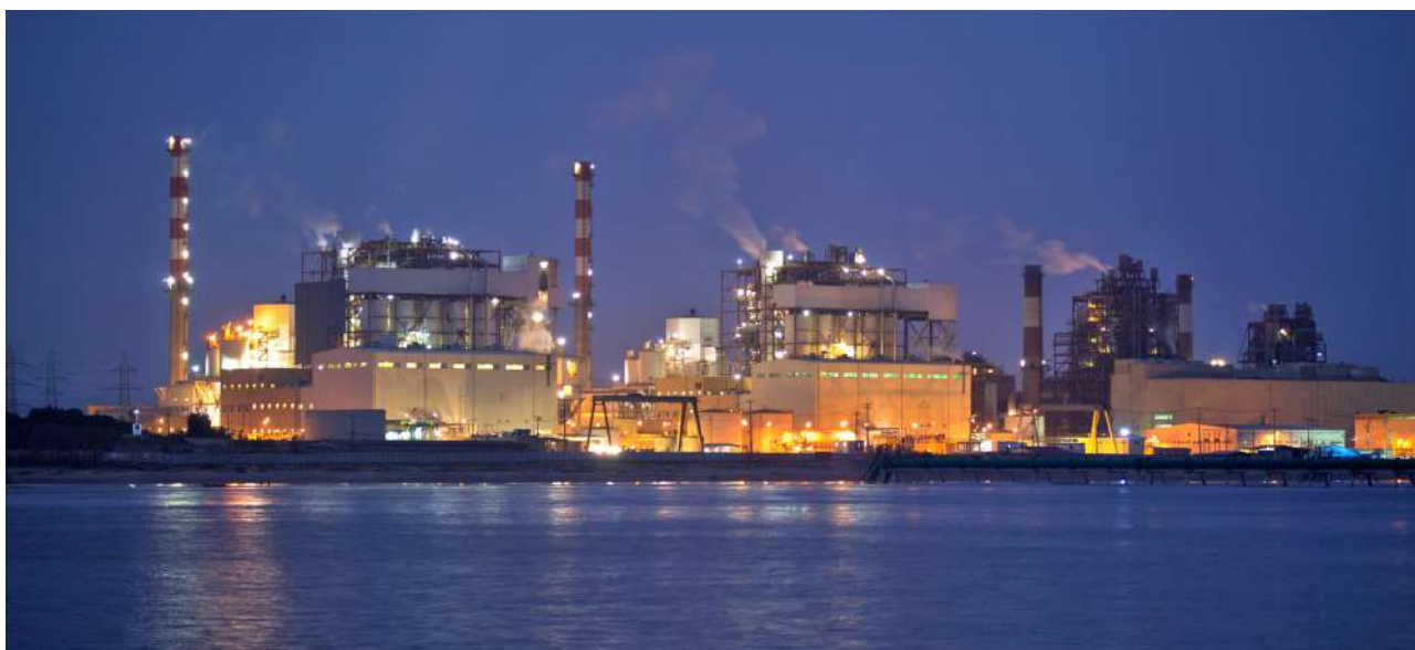
Central Ventanas, Región de Valparaíso, Chile.
