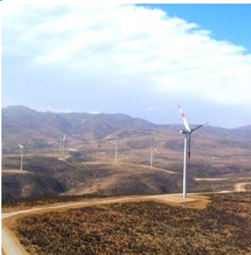
Parque eólico Los Cururos
