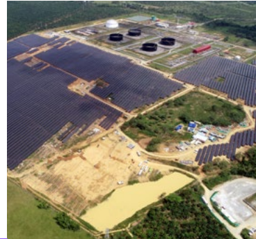
Parque solar San Fernando
